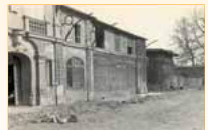
Nový závodní klub vyrostl na místě starého skleníku, správní budova a další klubovny spolu s loutkovým sálem z vedlejšího hospodářského stavení.
