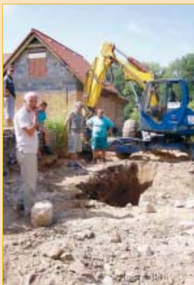
Při zemních pracích v ulici Na Kapli byly odkryty zbytky neznámého zdíva.
