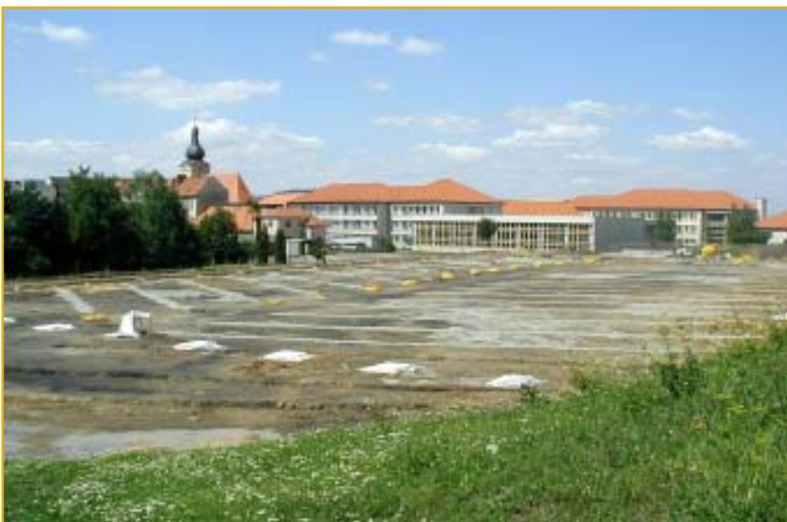
Oprava školního hřiště je důkladná a započala položením nové drenáže. Foto: -veb-
