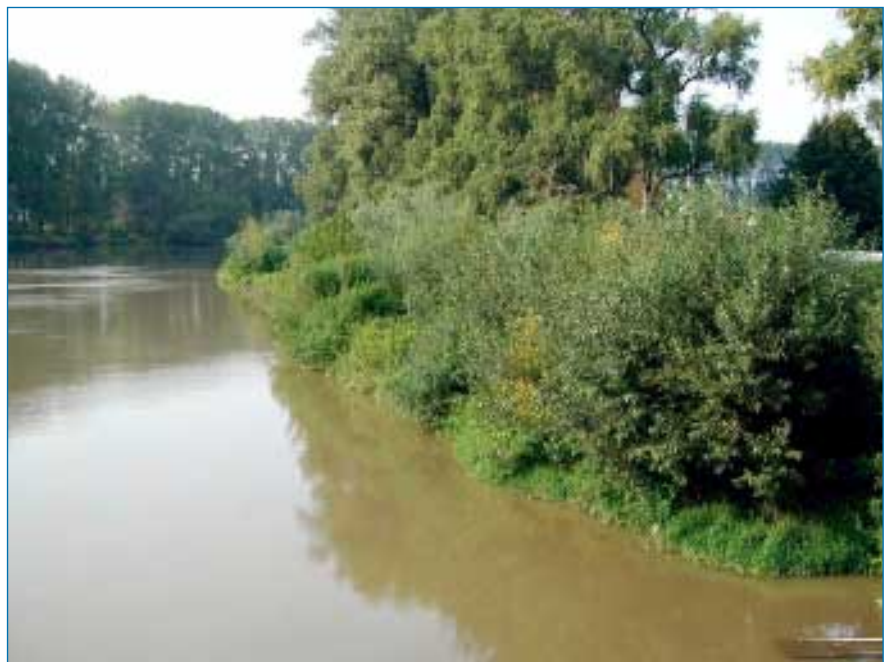
Před výstavbou protipovodňových hrází se břeh Moravy musí vyčistit od porostů. Společnou snahou realizátorů díle je ochrana zvířecích i lidských příbytků.
