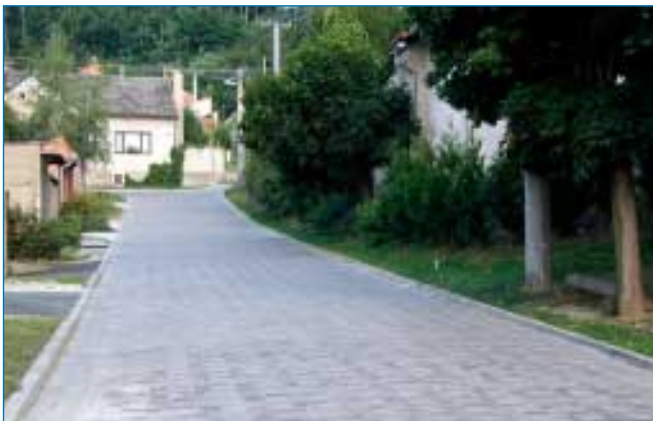
Ulice Hřbitovní po opravě.
