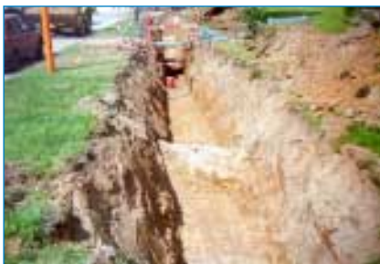
Kolize s kanalizací
