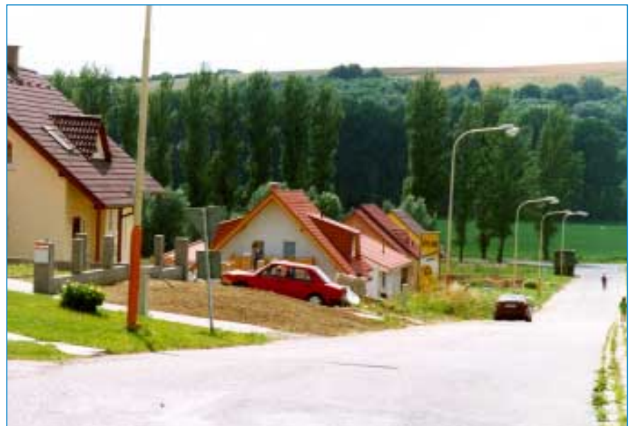
Napajedla se rozrůstá - výstavba nových domků v ulici K Pahrbku pokračuje a dává této části města nový příjemný vzhled. Foto vb
